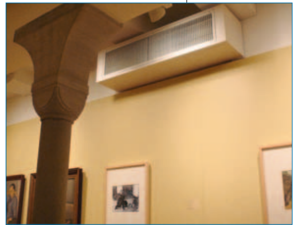
Kostenreduktion: eine Abluftöffnung für fünf Ausstellungenräume. (Fotos: BUS-House)
